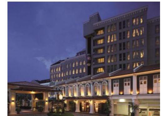
新加坡悦乐雅柏酒店 Existing Village Hotel Albert Court
